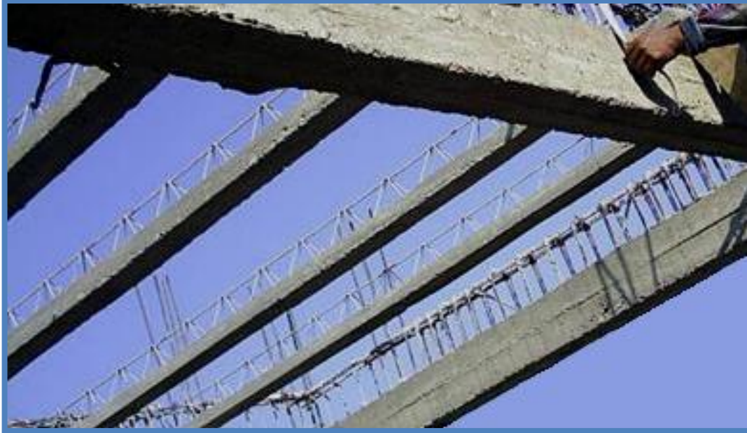
Foto 3 Colocado de la viguetas prefabricadas
