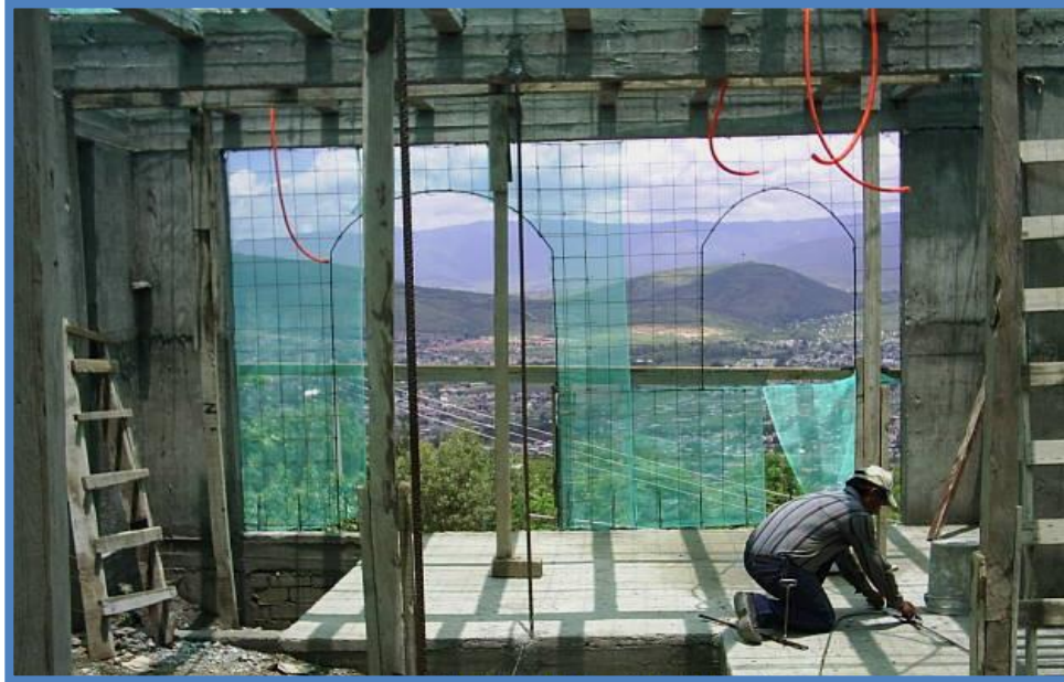
Foto 11 Adecuación de varillas de acero, malla electrosoldada y malla cimbra que conformaran los muros.
