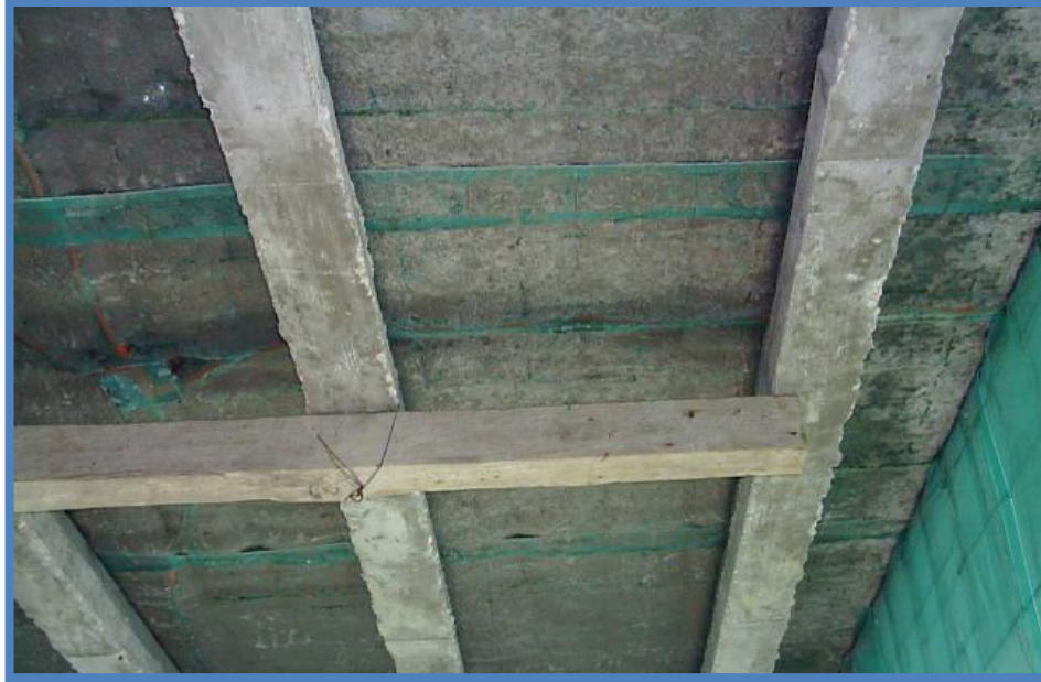
Foto 7 Vista interior de la losa de entrepiso, etapa de impregnación.
