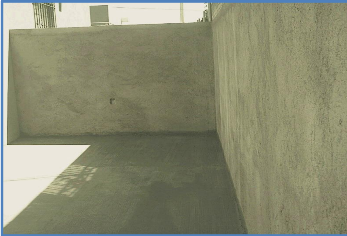
FOTOGRAFIA 12, CONSTRUCCIÓN MURO DIVISORIO EN COLINDANCIA CON ACABADO RÚSTICO.
