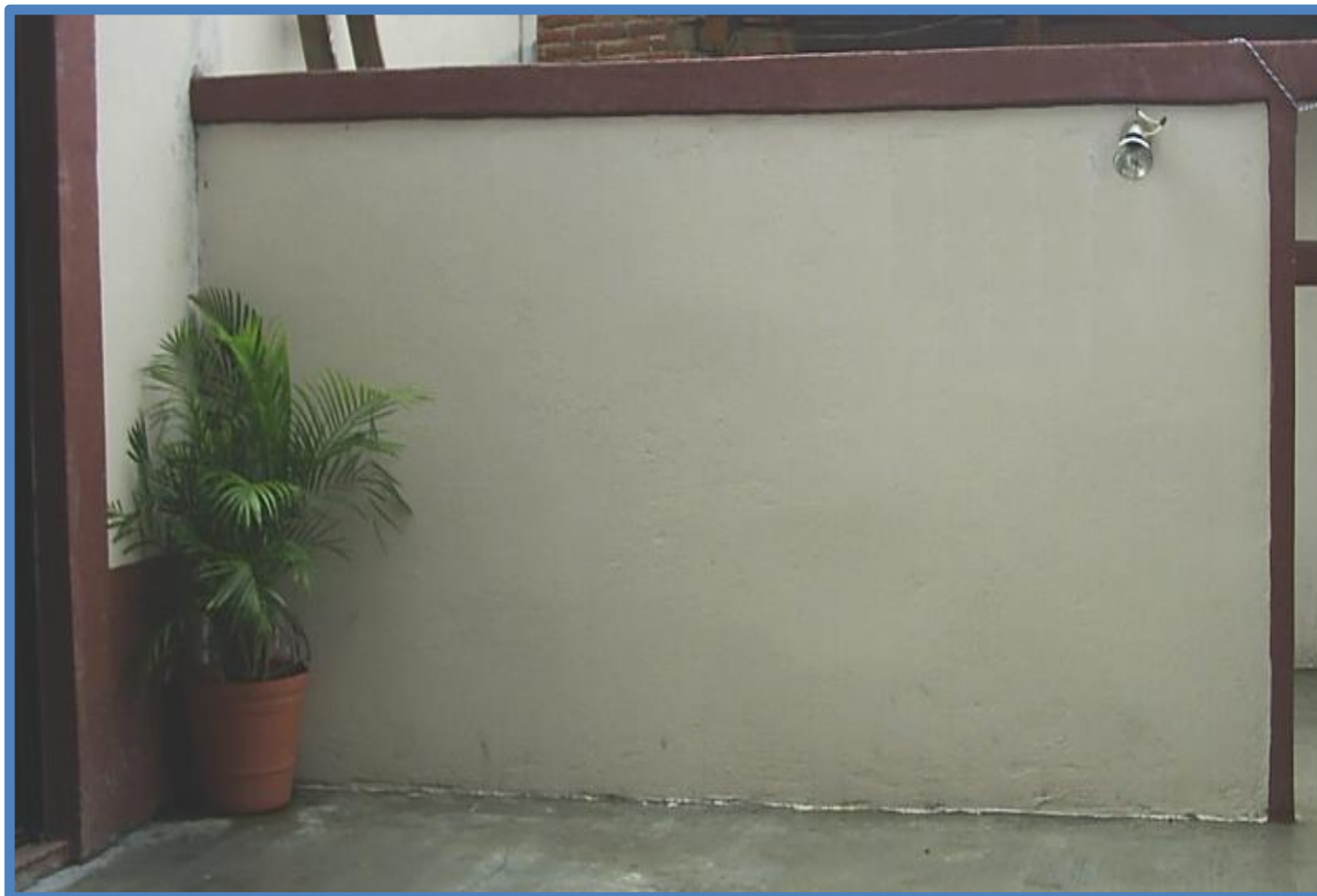
FOTOGRAFIA 5, MEJORAMIENTO HABITACIONAL CON EL MURO DIVISORIO.
