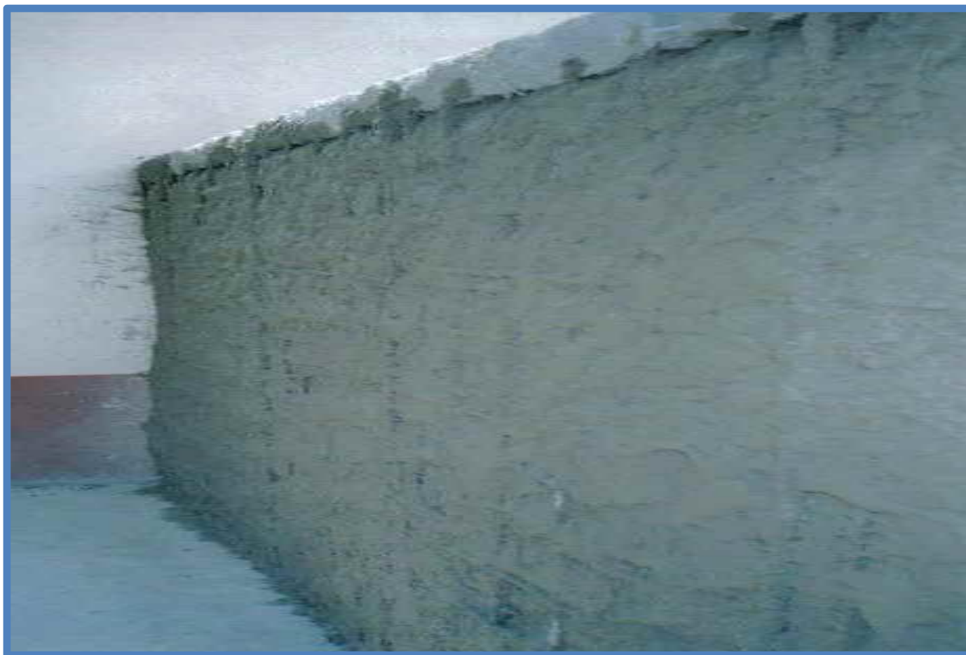
FOTOGRAFIA 4, ADECUACIONES CON MORTERO DE CEMENTO: ARENA, OBRA EN CONSTRUCCIÓN.
