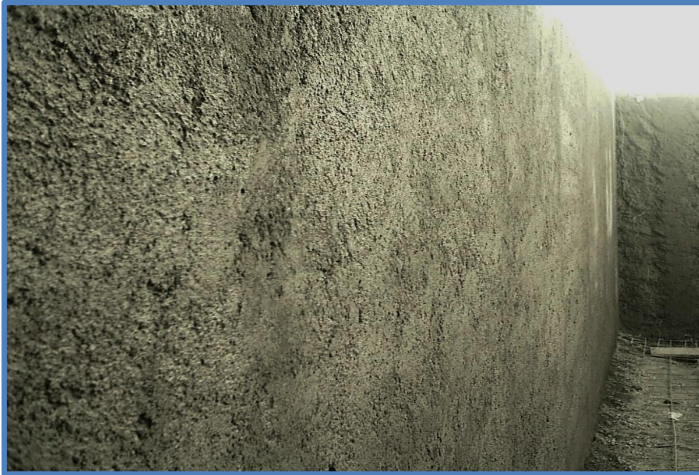
FOTOGRAFIA 11, CONSTRUCCION DE MURO DIVISORIO EN COLINDANCIA.
