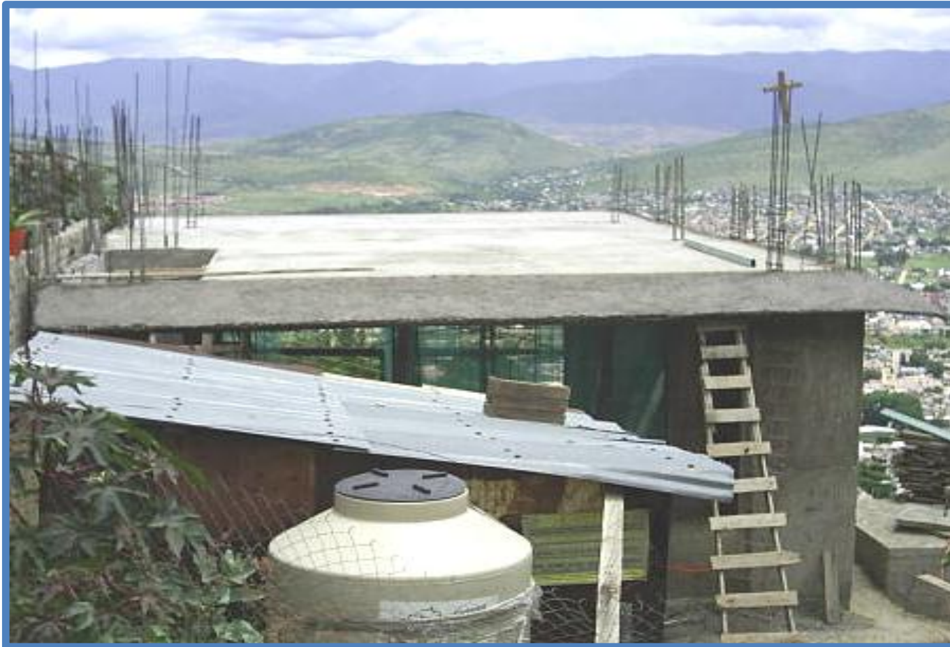
FOTOGRAFIA 15, COLADO DE LOSA DE CUBIERTA, VISTA EXTERIOR.
