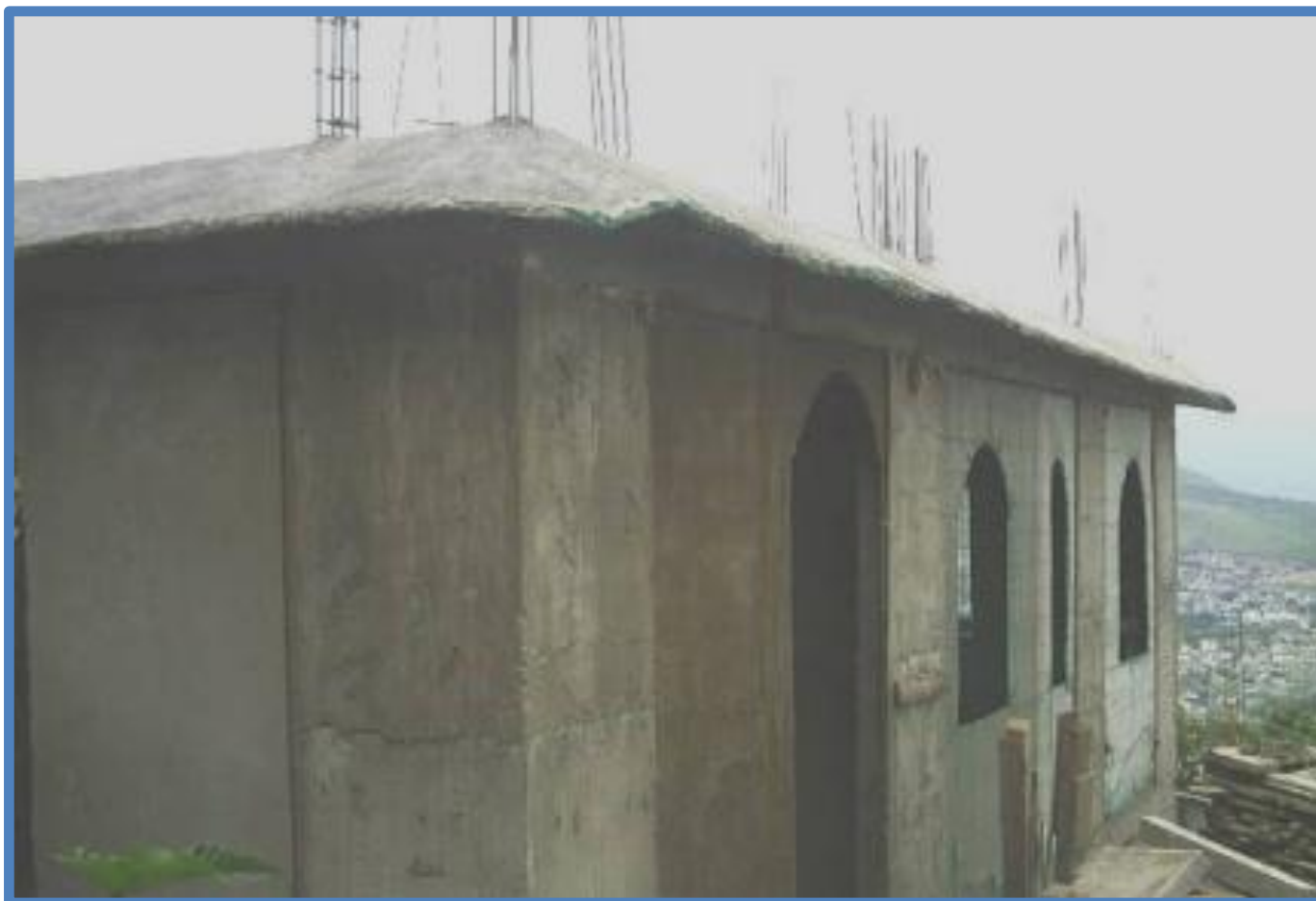
FOTOGRAFIA 20, CONSTRUCCIÓN DE MUROS Y LOSAS.
