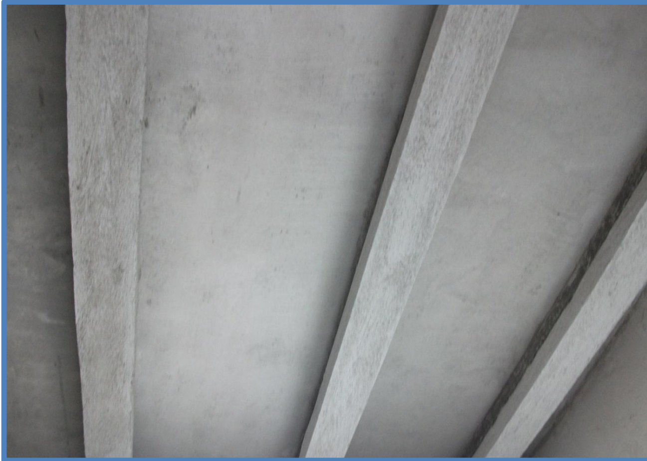
FOTOGRAFIA 16, VISTA INTERIOR DE LA LOSA DE CUBIERTA CON APLANADO LISO.
