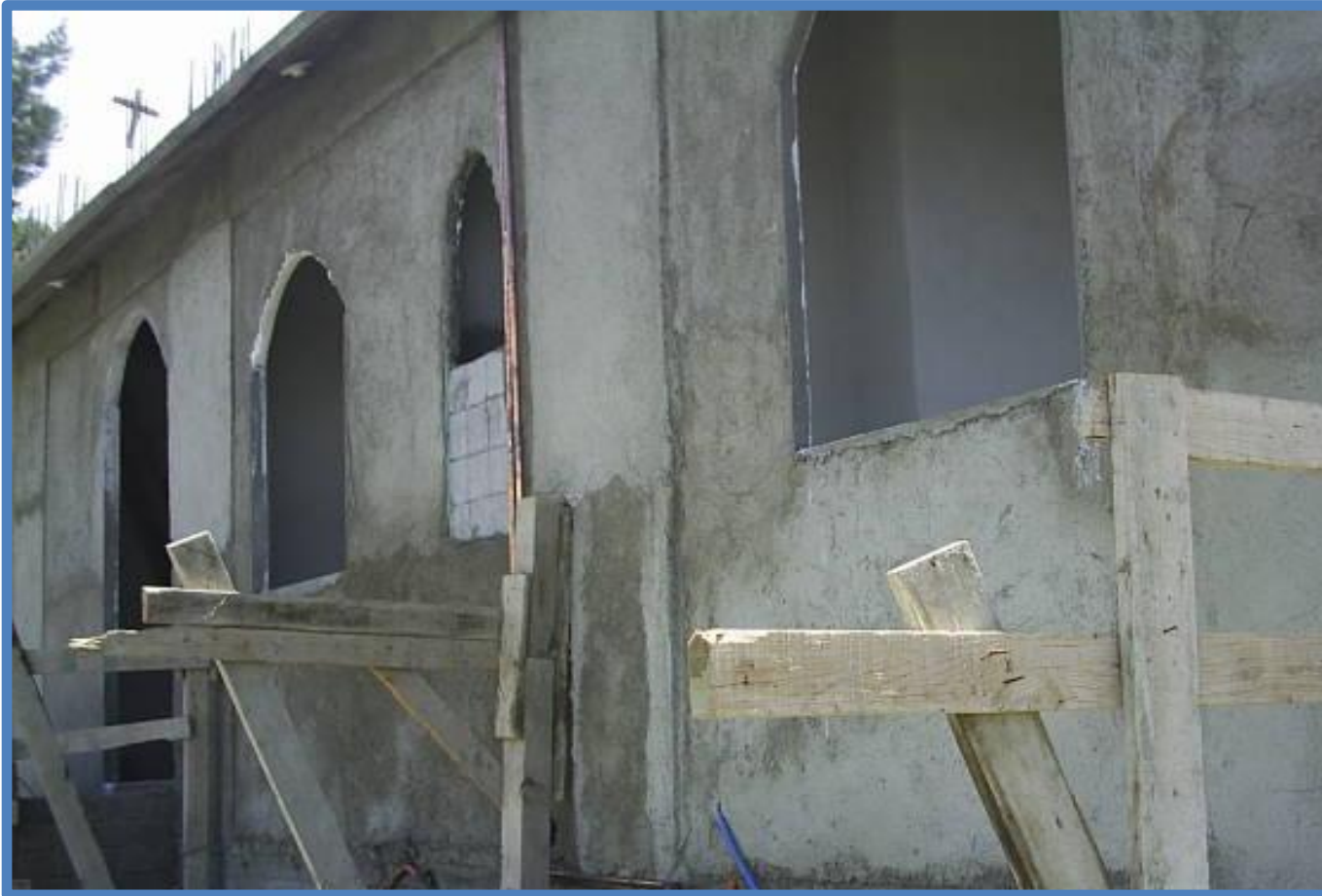
FOTOGRAFIA 9, CONSTRUCCIÓN DEL MURO DIVISORIO EN EL EXTERIOR DE LA VIVIENDA.
