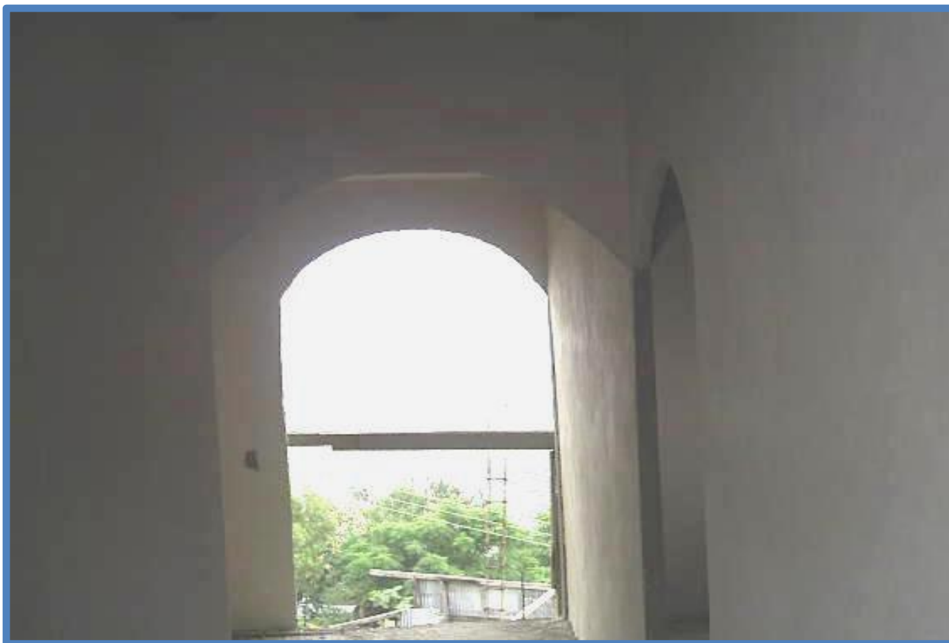
FOTOGRAFIA 7, VISTA INTERIOR, CONSTRUCCIÓN DE MUROS INTERIORES.
